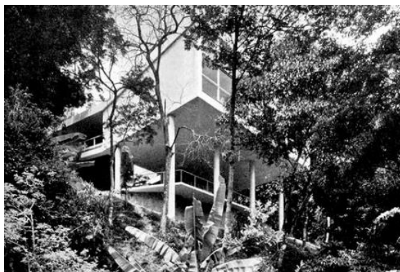
Figura 26 - Affonso Eduardo Reidy, Residência Carmem Portinho, Jacarepaguá, Rio de Janeiro, 1950. Vista a partir do solo. Fonte: BONDUKI, 2000.
